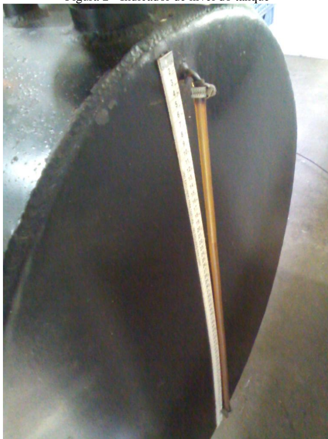
Figura 2 - Indicador de nível do tanque
