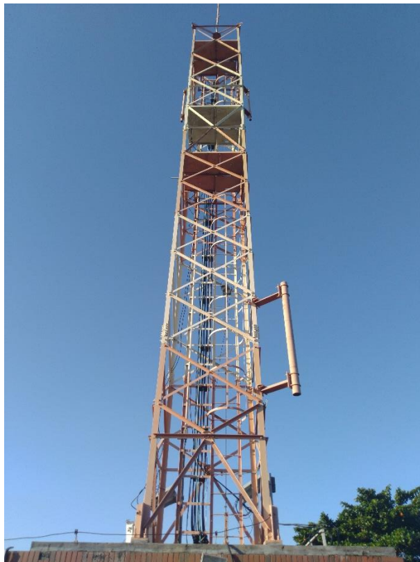
Figura 15 – Torre autoportante do prédio CT6 - UFES
