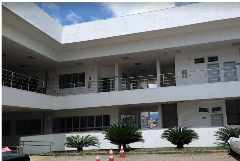
Figura 27 – Fachada de entrada aos laboratórios
