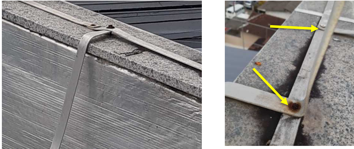
Figura 15 – Subsistema de descida. (a) Subida à borda, (b) Fixação atual.
