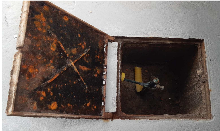
Figura 2 – Vista da caixa de inspeção
