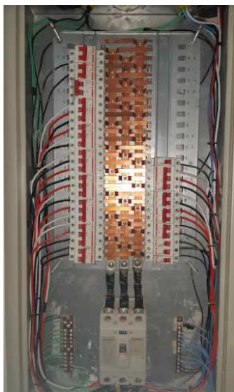
Figura 24 – Quadro 2º pavimento (QD-2PV_HVAC). (a) Quadro, (b) detalhe construtivo.
