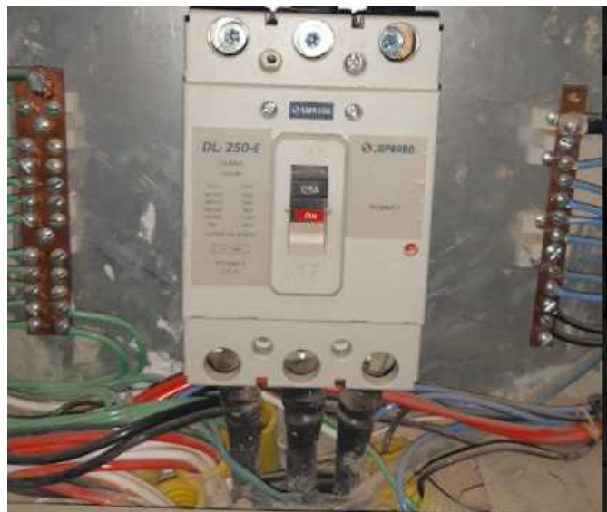
Figura 24 – Quadro 2º pavimento (QD-2PV_HVAC). (a) Quadro, (b) detalhe construtivo.
