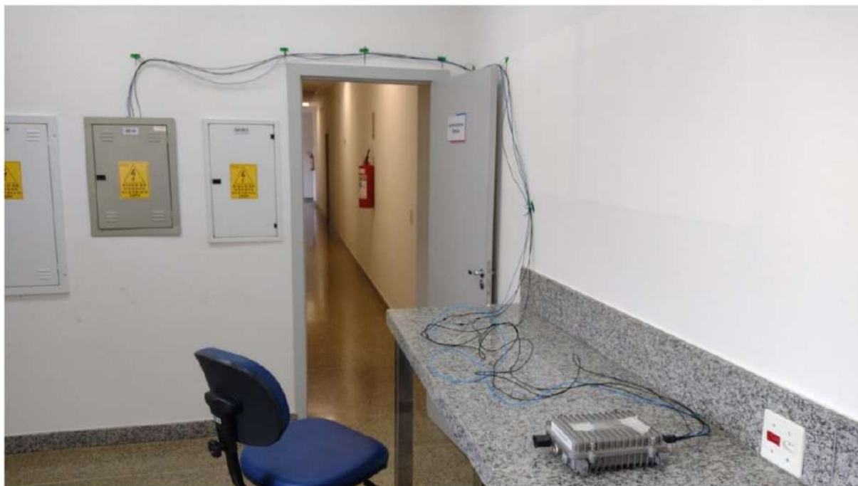
Figura 14 – Instalação do TDR1 no QD-08
