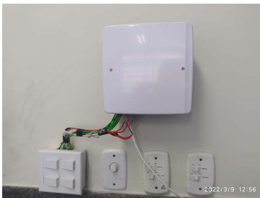
Figura 39 – Finalização da montagem em sala de aula do Colégio Estadual do Espírito Santo.
