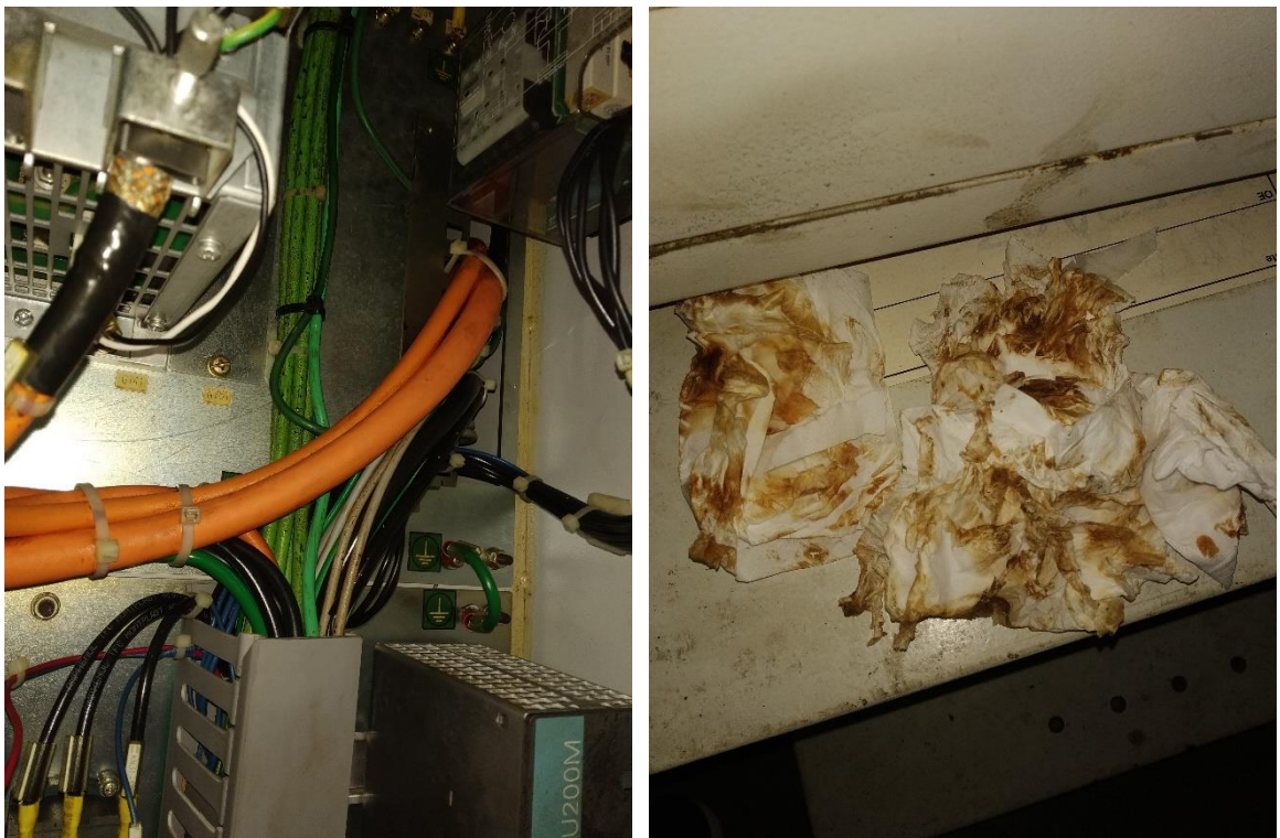
Figura 21 – Cabos elétricos após limpeza e papel com álcool isopropílico utilizado
