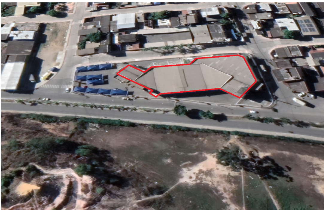
Figura 8 – Vista aérea do local de instalação.
