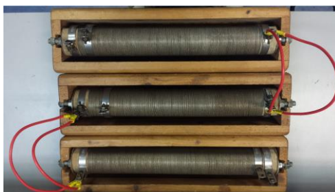
Figura 15 – Resistores utilizados para o ensaio de sobrecarga.
