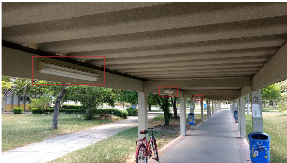
Figura 22 - Disposição das luminárias do corredor norte
