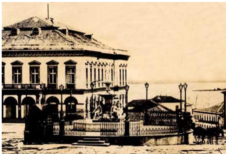
Figura 1 - Praça da Matriz, 1874, postes com iluminação a gás
