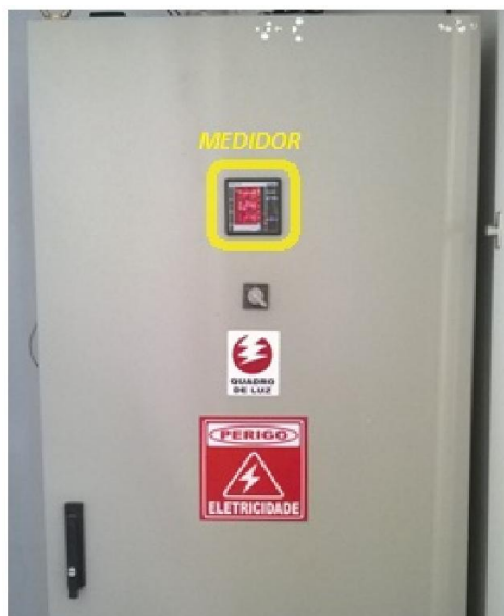
Figura 9 – Instalação do medidor
