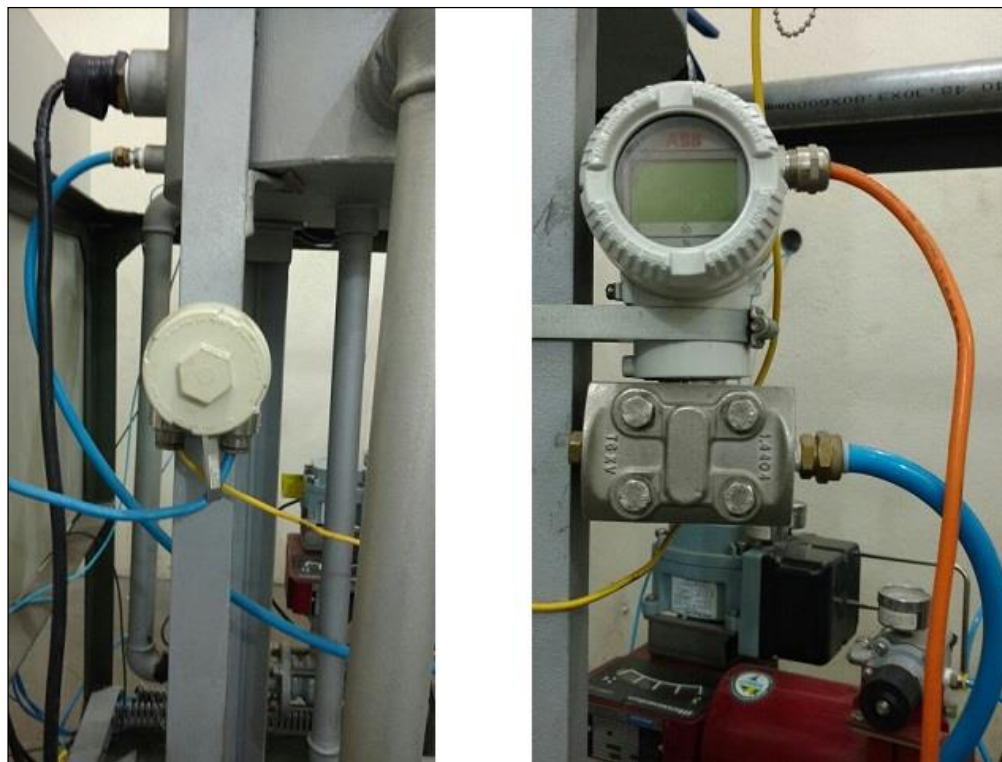
Figura 4 – Transmissor de temperatura TF12-Ex (esquerda) e transmissor de pressão diferencial 2010TD (direita)
